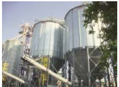
Рис. 3 – Зерносховища з конусним днищем
