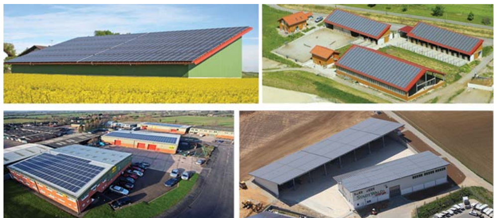
Рис. 3 – Складські та інші сільськогосподарські приміщення фірми «Wolf System GmbH», дахи яких покриті геліопанелями
