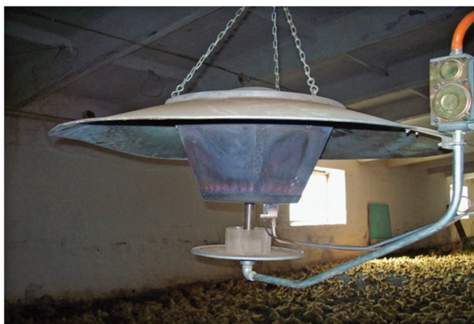
Рис. 2 – Брудер газовий «EV2 Class D» у пташнику для вирощування каченят
