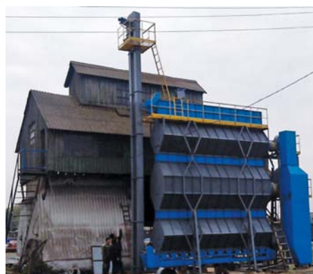
Рис. 2 – Загальний вигляд зерносушарки типу СЗМ-16 з теплогенератором на твердому паливі
