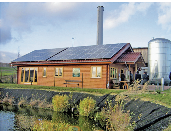
Рис. 5 – Геліопанелі на дахах виробничих приміщень біоенергетичного селища Юнде
