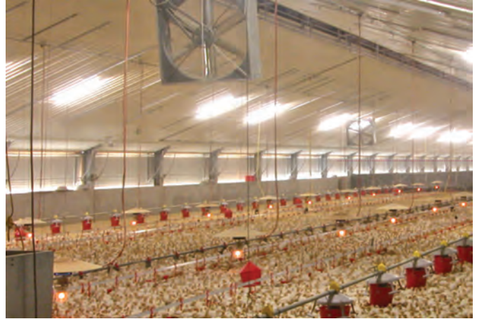
Рис. 5 – Швидкозбірне приміщення для утримання індиків на відгодівлі фірми «Вольф Систем»
