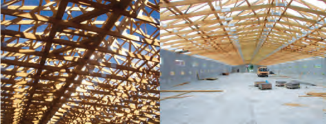
Рис. 7– Кровляні конструкції даху приміщень «Вольф Систем»
