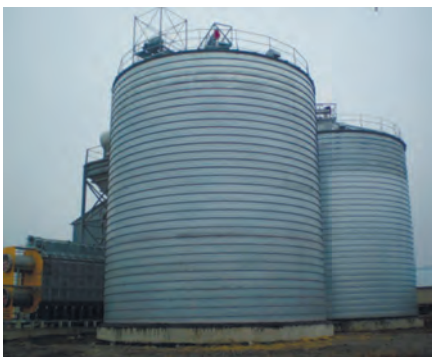
Рис. 3 – Металевий спіральньо-фальцевий силос типу МСФС
