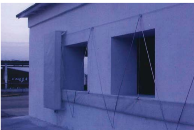
Рис. 29 – Стіна корівника, обладнана боковими вентиляційними шторами
