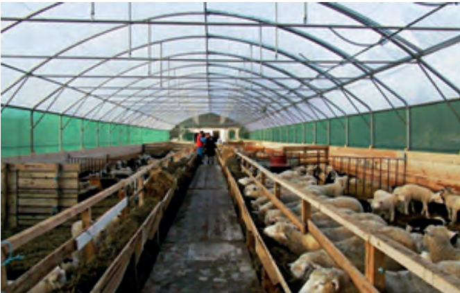
Рис. 3 – Будівля для утримання овець
