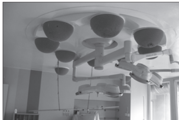
Рисунки 2. Система з 8 подавачів стерильного повітря над операційним столом
