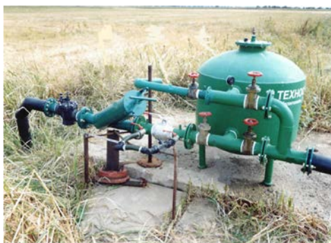
Рисунок 2 – Фільтрувальна станція та вузол приготування і подачі добрив з поливною водою
