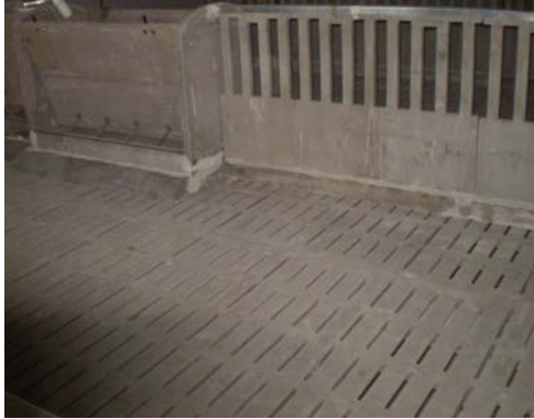
Рисунок 6 – Загальний вигляд бетонної щілинної підлоги
