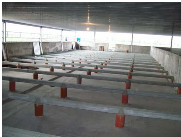
Рисунок 4 – Гнойова ванна в приміщенні для відгодівлі свиней (підготовка до монтажу щілинної підлоги)
