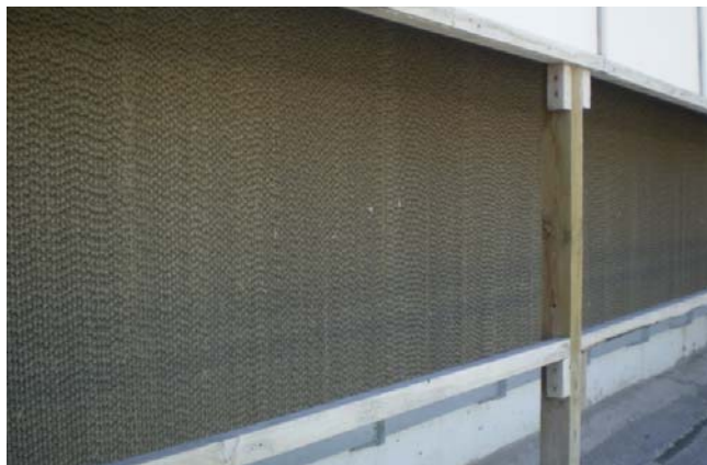
Рисунок 4 – Зволожувач ТББАВ
