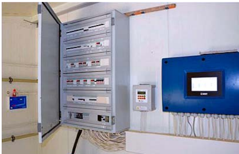
Рисунок 8 – Прилади автоматичного управління виробничим процесом у пташнику
