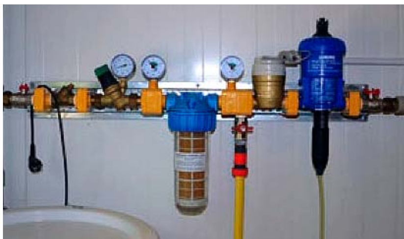
Рисунок 9 – Пристрої для очищення води і її санації та дозування ліків і вітамінів
