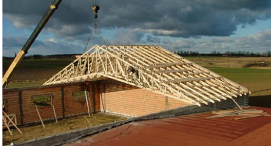
Рисунок 2 – Дерев'яні конструкції типу «ножиці»
