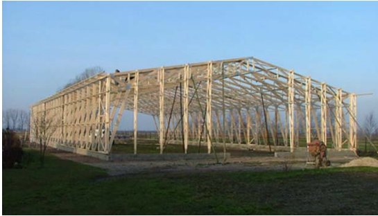
Рисунок 1 – Каркас будівлі з дерев'яних конструкцій
