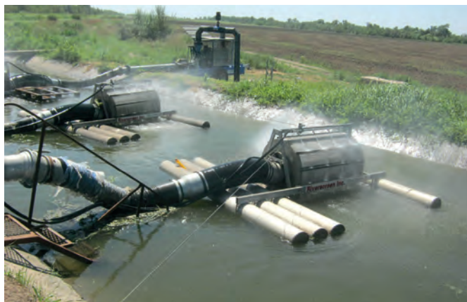
Рисунок 4 – Водозабірні пристрої насосних станцій з фільтрами активного типу
