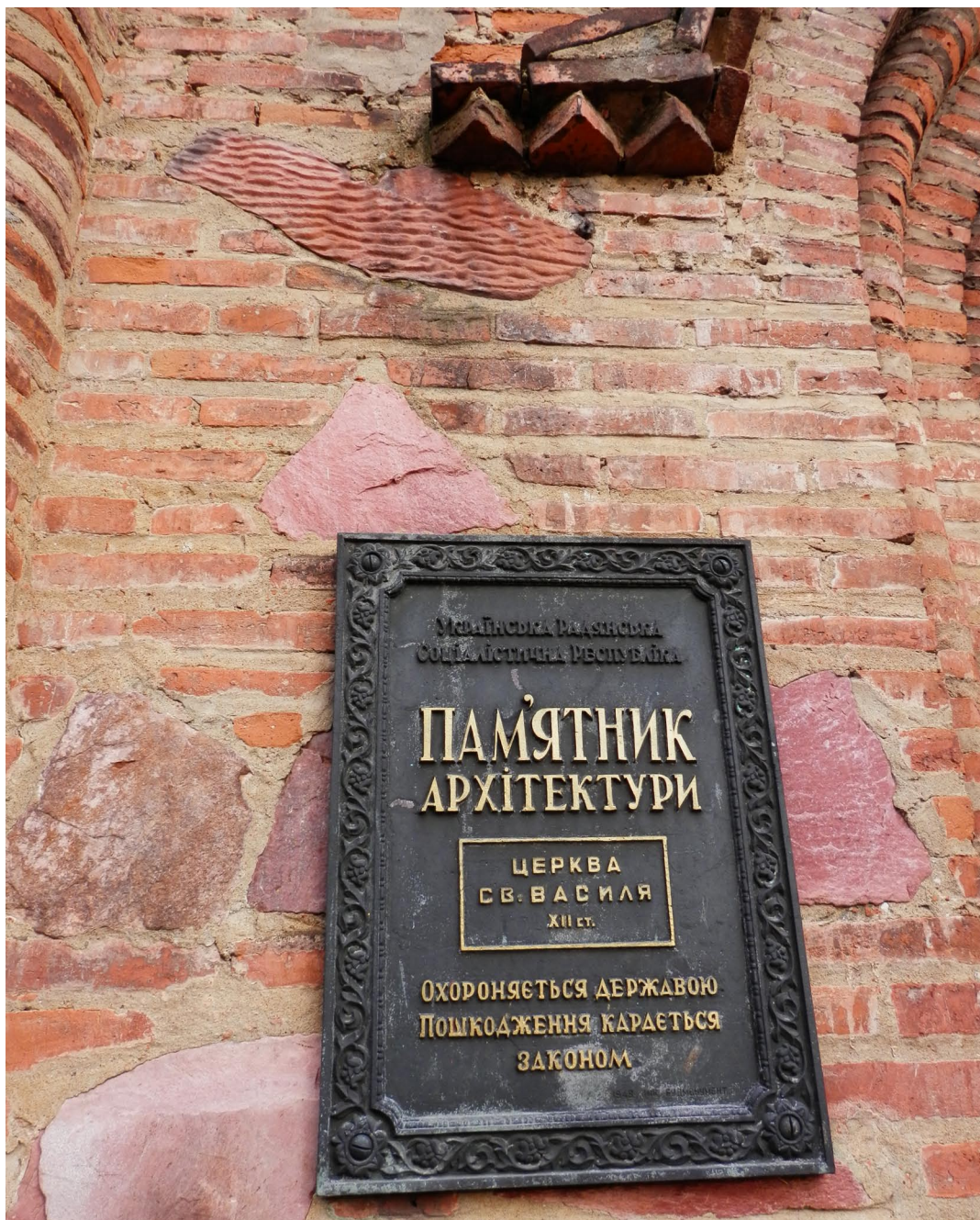
Фото 12. Фрагменти овруцьких кварцитів серед цегляної кладки церкви Святого Василя XII ст. у м. Овруч
