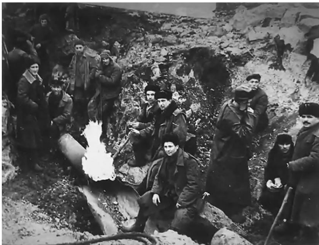
Фото 2. Шебелинское газоконденсатное месторождение в Украине. Совещание по проблеме образования газогидратных пробок в газопроводе (18 февраля 1957 года)
