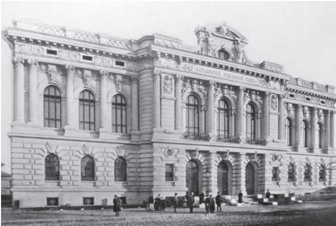
Іл. 1. Земельний банк на Миколаївській площі в Харкові. Арх. О. М. Бекетов. 1896–1898 рр. Фото поч. XX ст.
