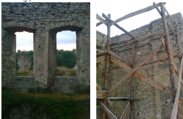
Фото 15. Ремонтно-реставраційні роботи в замку
