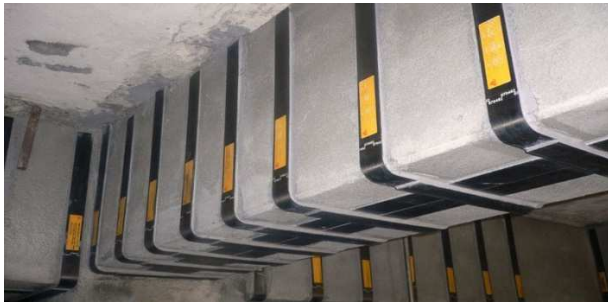
Рисунок 1 – Балочні конструкції підсилені зовнішнім армуванням
