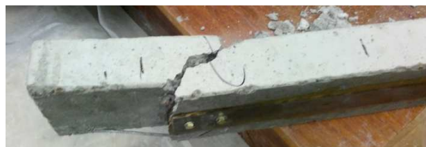
Рисунок 6 – Характер руйнування балки, підсиленої металевими смугами з кріпленням анкерами на краях (серія №5)
