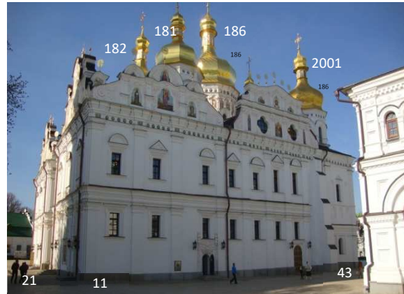
Рисунок 2 – Надкупольні яблука зі станції ST2: Успенського собору – 5; кути цоколя – 3
