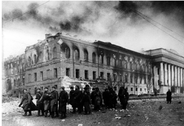
Рис. 1. Червоний корпус університету одразу після визволення Києва від нацистських загарбників. Вигляд пошкодженого південного крила будівлі з вул. Володимирської та частково Ботанічного саду. Листопад 1943 р.
