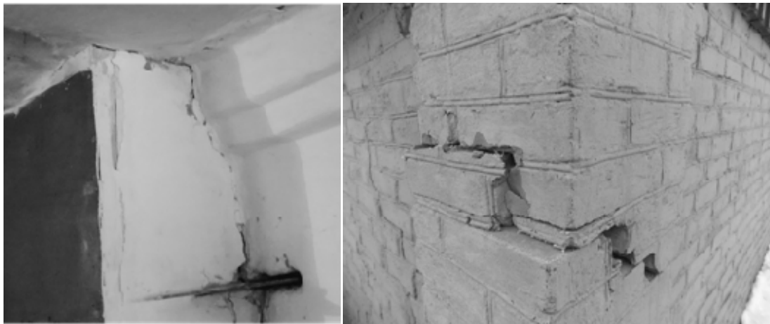
Рис. 4. Фотографія стін будівель, які зазнали руйнувань в селах з 6-ти бальними значеннями інтенсивності землетрусу 03.02.2015
