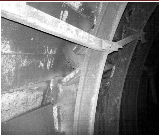
Рис. 5. Явление складывания затяжки «в гармошку». Шахта «Комсомолец Донбасса»
