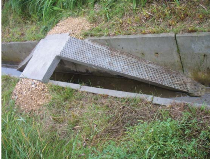
Рис. 5. Внутрішній варіант захисної конструкції у дренажному рові.
