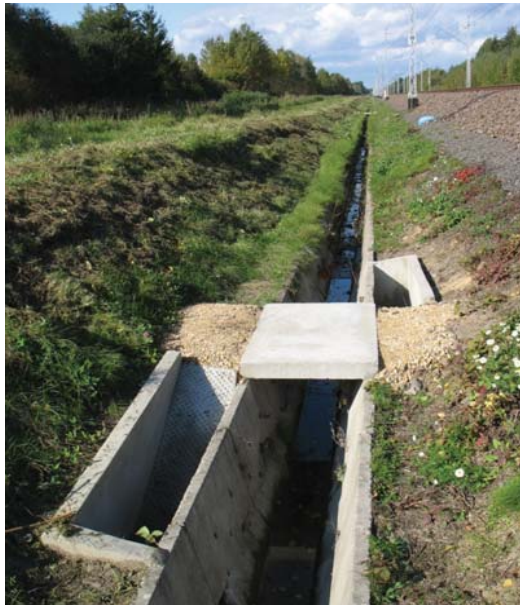
Рис. 2. Паралельний варіант захисної конструкції у дренажному рові.
