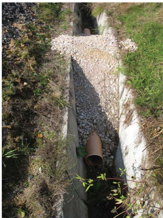
Рис. 4. Трубний варіант захисної конструкції у дренажному рові.
