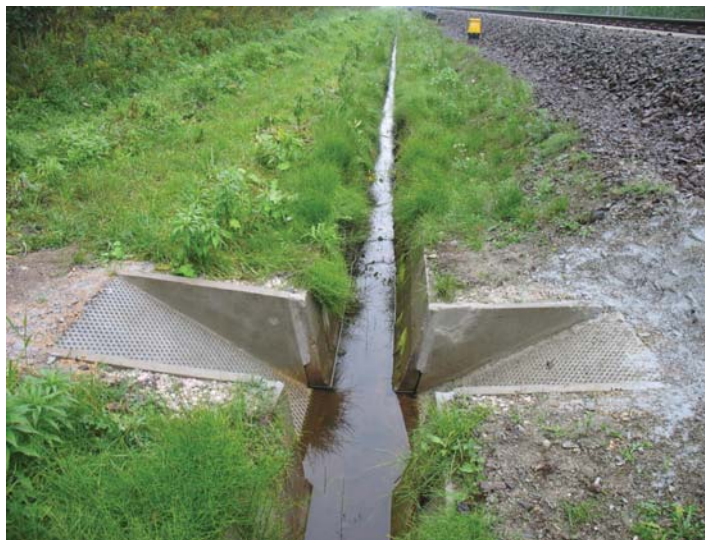
Рис. 3. Перпендикулярний варіант захисної конструкції у дренажному рові.
