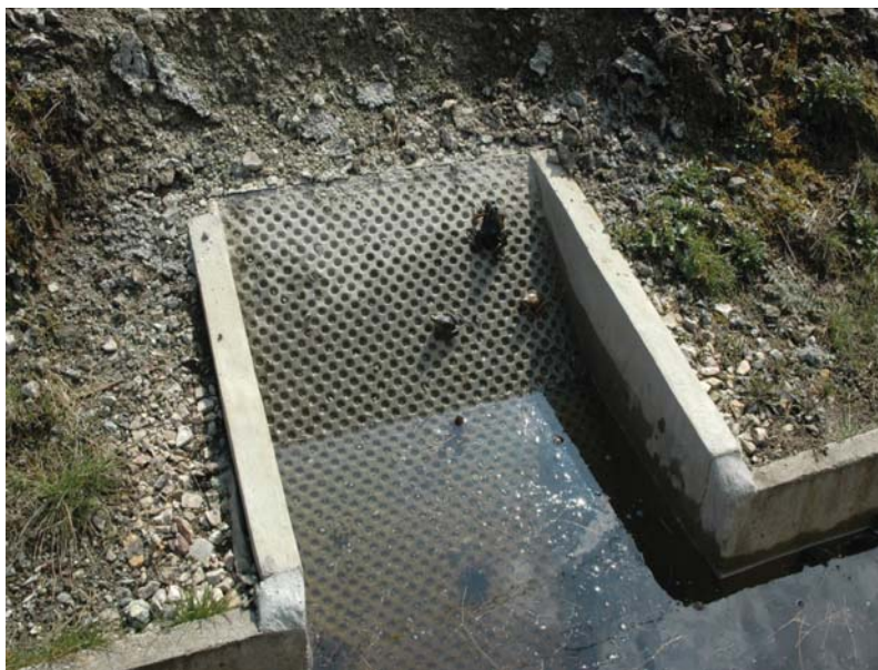
Рис. 6. Особини земноводних, які самостійно знаходять вихід із дренажного рову, використовуючи захисну конструкцію перпендикулярного типу.
