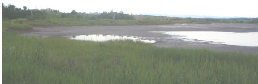
Рис. 4. Намив пляжів хвостів збагачення по внутрішньому контуру дамби секції № 2 Стебницького хвостосховища суттєво поліпшив би гідродинамічну стійкість та мінімізував ризики виникнення аварійної ситуації.
