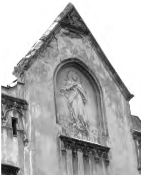
Рис. 1. Аттик будинку на вул. генерала Чупринки, 48. 1905 р.
