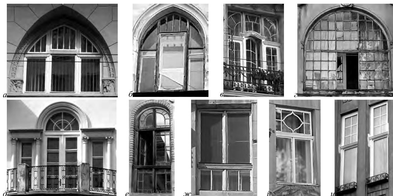
Рис. 14. Вирішення віконної столярки в раціональній сецесії: а – вул. Січових Стрільців, 12 (неоготика); б – вул. Дудаєва, 15 (неоготика); в – вул. Дорошенка, 19 (необароко); г – вул. Кременецька, 10 (необароко); д – вул. Франка, 150 (неокласицизм); е – вул. Хмельницького, 125; ж – вул. Галицька, 21; і – вул. Конопницької, 4; ii – вул. Пекарська, 49
