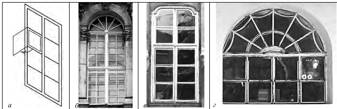
Рис. 7. Столярка класицизму: а – характерна схема відкриття класицистичного вікна (креслення О. Заречнюк); б, в – вікна кол. колегії Піарів; г – вікно Оссолінеуму
