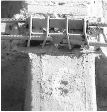
Рис. 4. Процес виконання підсилення горизонтальних ребер панелей: а – закріплення кільцевої арматури на підсилені закладних деталях панелей; б – між закладними деталями попередньо напружені арматурні стрижні поєднані між собою хомутами та зафіксовані до існуючої арматури горизонтальних ребер
