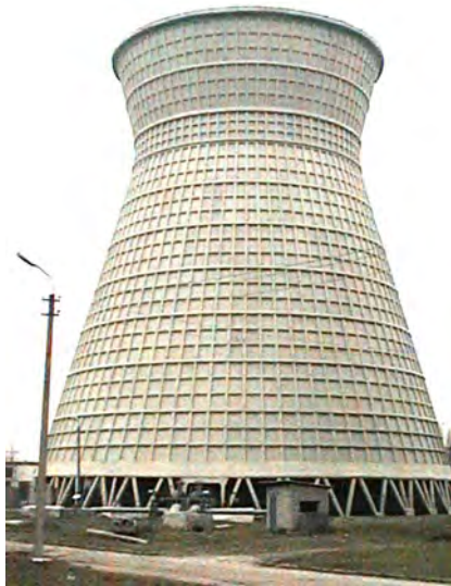
Рис. 5. Збірна залізобетонна градирня Дарницької ТЕЦ після реконструкції
