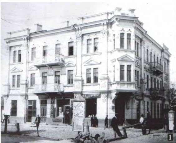
Рис. 2. Проскурівська, будинок та аптека Деревосєдова, 1890 р, сьогодні: Приміщення "Укртелекому"
