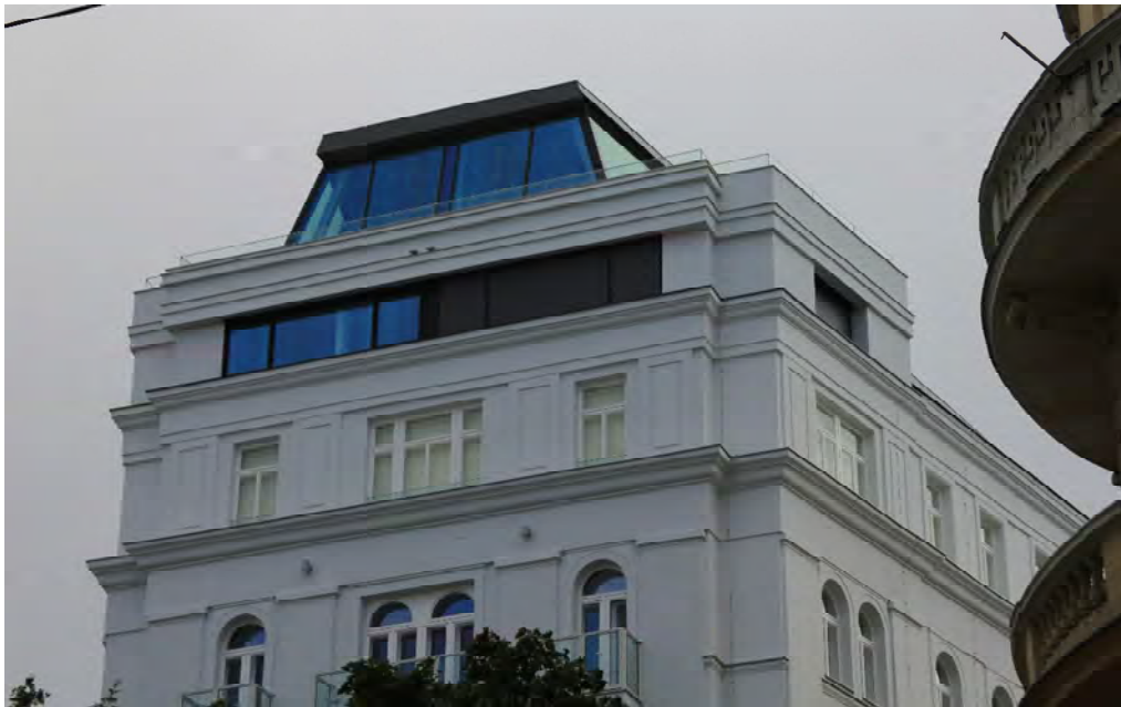
Рис. 5. Використання стрічкових вікон. Відень, Австрія [фото автора]
