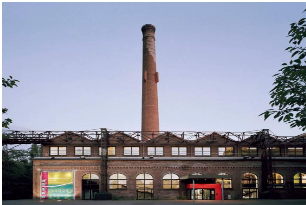
Рис. 5. Фасад колишнього млина після реконструкції (м. Ерстейн, Франція) [4]
