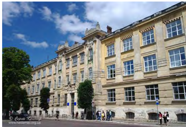
Рис. 18. Школа по вул. Снопківській, 47 (фото автора)
