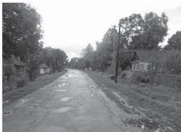
Рис. 13. Використання проїзної частини для пішохідного руху, деградація тротуарів
