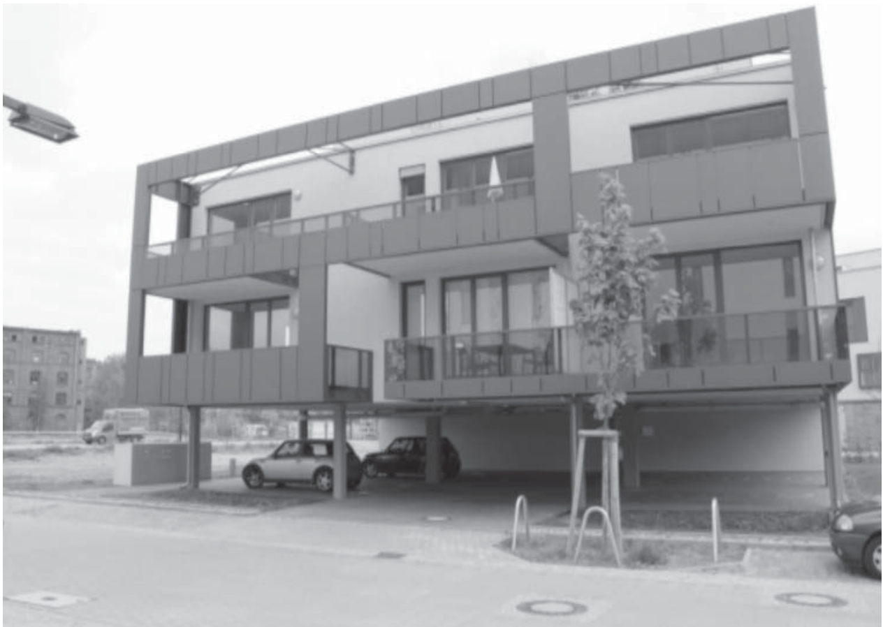
Рис. 2. Облаштування паркінгу під будинком на опорах. Берлін [8]
