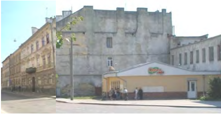
Рис. 2. Група з чотирьох будинків № № : 9,11,13, 17,17а, на вул. Під Дубом (зліва – направо)
