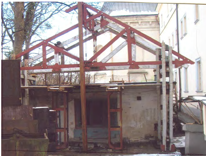
Рис. 5. Дослідна конструкція каркаса одноповерхового будинку
