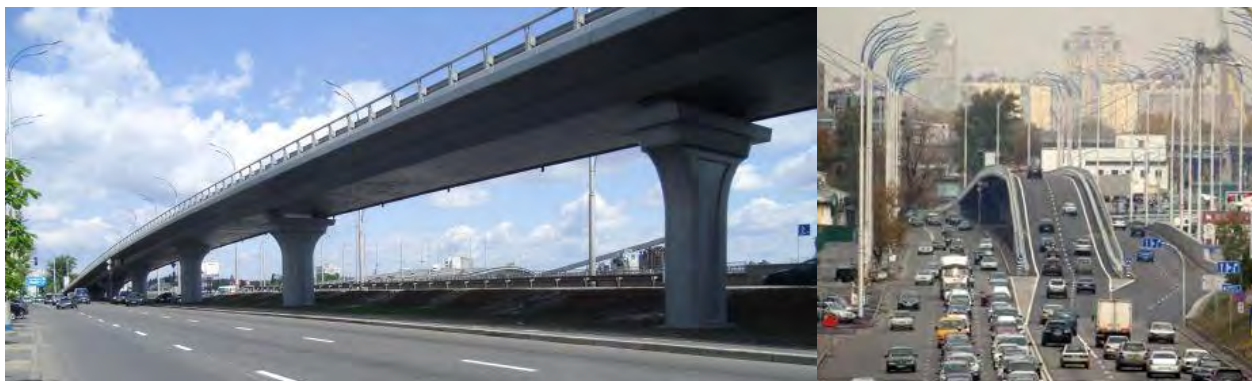
Рис. 7. Загальний вигляд естакади
