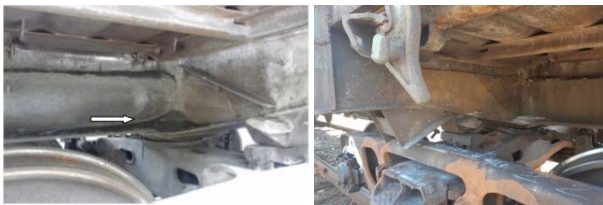
Рис. 2. Залишки вантажу на несучих елементах конструкції напіввагона
