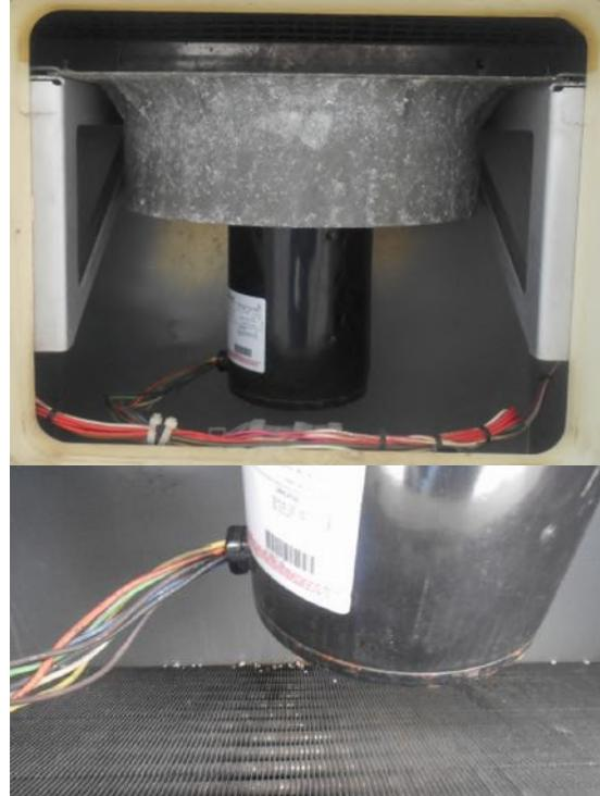
Рисунок 1 - Зовнішній вигляд пристрою трубчастого випарника холодильної установки (внизу) із вентилятором від виробника Carrier Transicold
