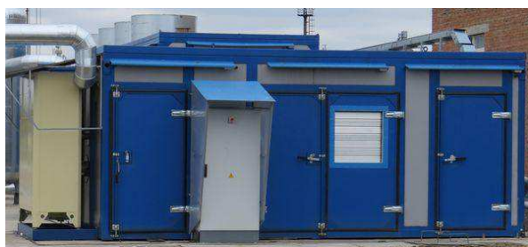
Рисунок 12 – Модуль компресора низького тиску станції ААВН-40/25 У1
