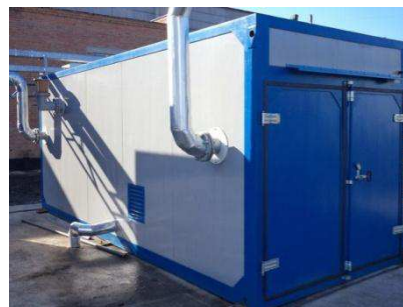
Рисунок 13 – Модуль підготовки стисненого повітря станції ААВН-40/25 У1
