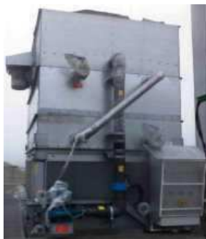
Рисунок 5 – Градириня з автоматичним насосним вузлом
