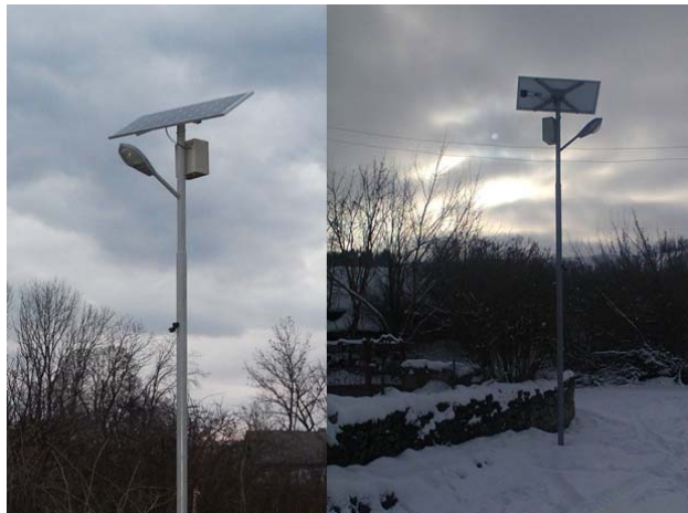
Рис. 2. Автономні опори освітлення на вулицях сіл Хмельницької області
