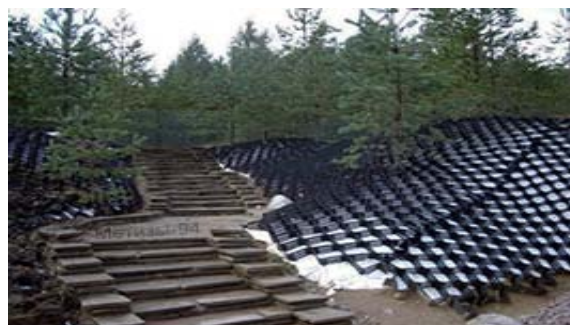
Рис. 2. Використання георешітки разом з геотекстилем
