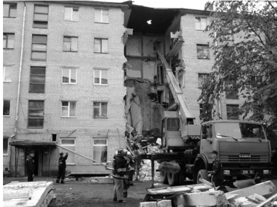
Рис. 6. Обрушення п'ятиповерхового будинку, м. Луцьк
