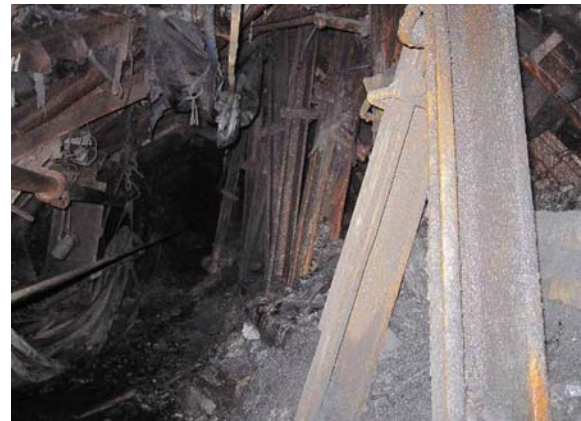
Рис. 2. Состояние крепи и пород почвы 8-го западного конвейерного штрека пласта m_3 на расстоянии 40 м за очистным забоем на контрольном (а) и на первом (б) экспериментальных участках
