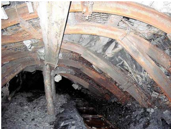
Рис. 2. Состояние крепи и пород почвы 8-го западного конвейерного штрека пласта m_3 на расстоянии 40 м за очистным забоем на контрольном (а) и на первом (б) экспериментальных участках
