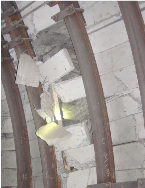
Рис. 3. Деформация межрамных затяжек
