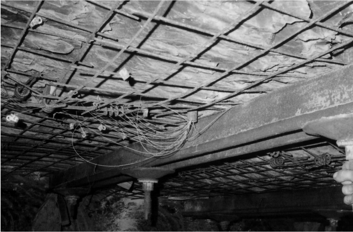
Рис. 2. Общий вид замерной станции №3
