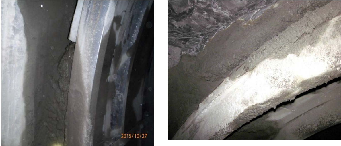
Рис. 9. Торкрет-смесь «Текхард» уложенная за крепь выработки: а – в боках, б – в кровле
