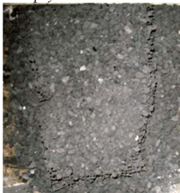
Рис. 9. Загальний вигляд породної опори, яка армована металевими сітками
