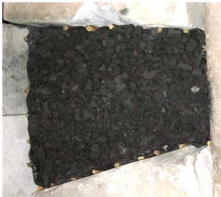
Рис. 6. Загальний вигляд породних конструкцій у момент їх зведення
