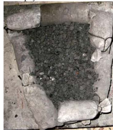
Рис. 10. Загальний вигляд породної опори зі стінками з мішків
